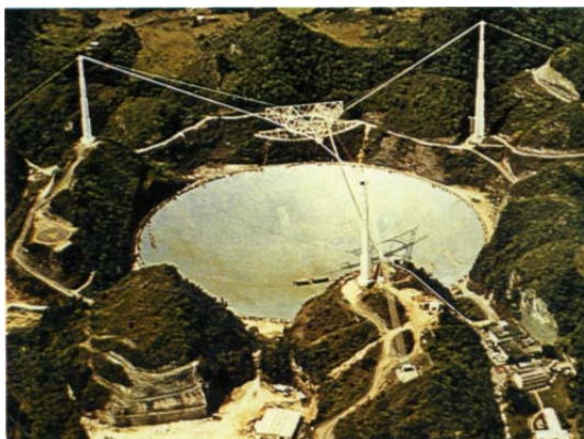
Fig. 3. El gran telescopi d'Arecibo (Puerto Rico). El col·lector, de 305 m de diàmetre, està constituït per 27.000 panells d'alumini densament perforats per a permetre el drenatge de l'aigua de la pluja. L'instrument està orientat cap al zenit però el receptor que, sostingut per tres pilars es troba en el focus del col·lector, es pot desplaçar lateralment per poder observar fins una distància de 20° del zenit. Per les seves grans dimensions, aquest instrument és adequat per a ser utilitzat com a transmissor en estudis amb radar..
