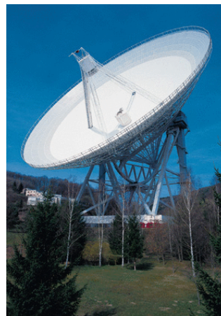
Fig. 4. El radiotelescopi d'Effelsberg (Alemanya). També la muntura d'aquest instrument és altazimutal. El casquet més intern (de 60 m de diàmetre), que en cap punt difereix en més de 0.6 mm del paraboloide ideal, s'utilitza per a les ones mil·limètriques. La superfície completa s'utilitza per ones compreses entre 6 i 92 cm.
