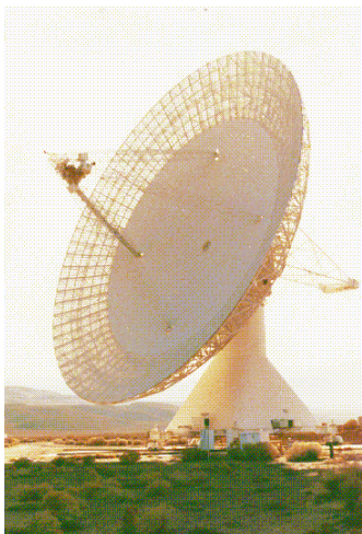
Fig. 1.- El radiotelescopi de Owens Valley, a Califòrnia. El paraboloide de 40 m de diàmetre, amb muntura altazimutal, treballa amb ones compreses entre un centímetre i un metre.
